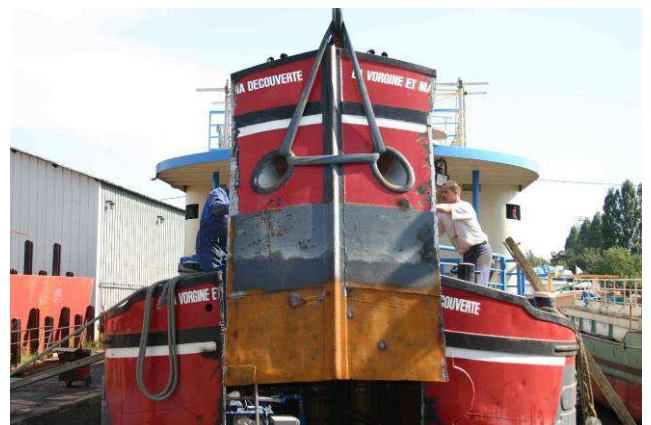
Aout 2007 - Ouverture du peak avant pour intégrer la station d'épuration
